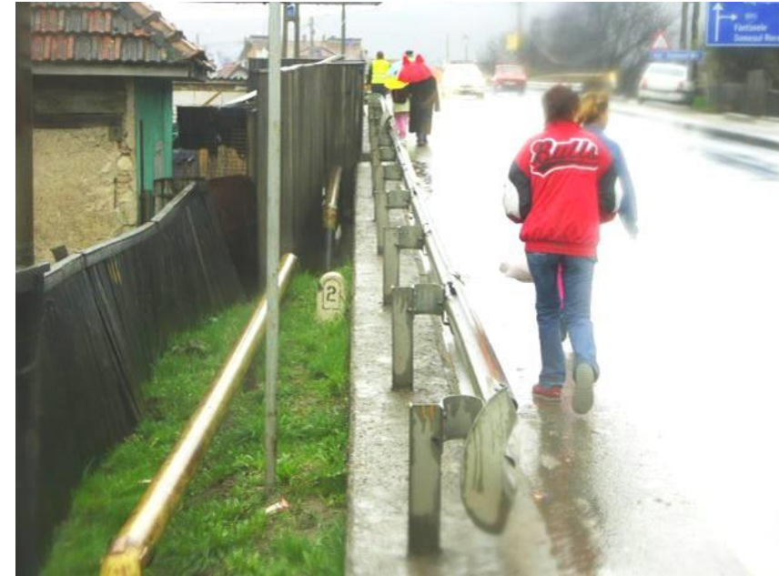
Lëvizja jo adekuate për këmbësorë: Serbi (Burimi: Typical Road Safety Engineering Problems – Solutions)
