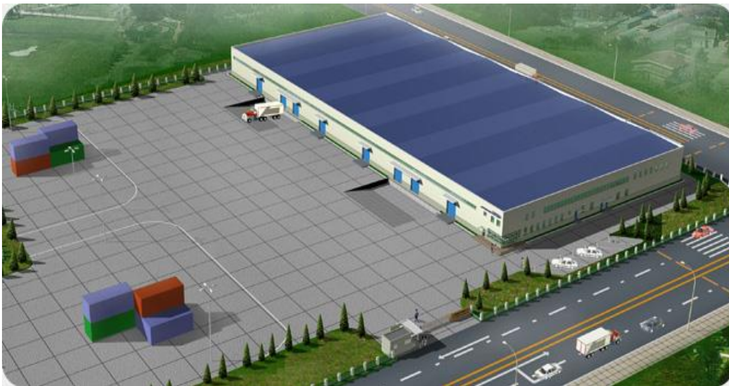
Foto 1. Qendra logjistike e tipit përmbledhëse – distribuive.
